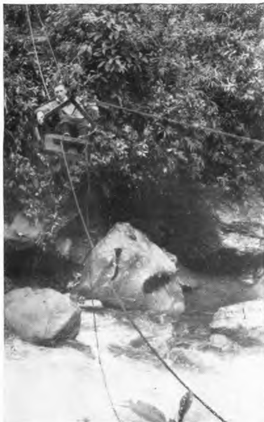
EQUATORE - Soggiovia di fortuna improvvisata per superare gli abissi dei grandi fiumi.
